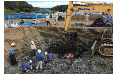
廃棄物処分場での現地調査の様子
