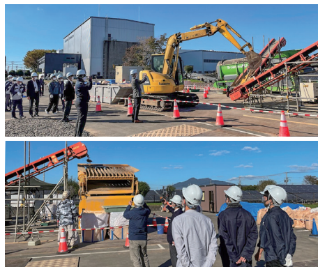
実大スケールでの災害廃棄物のふるい分け試験
