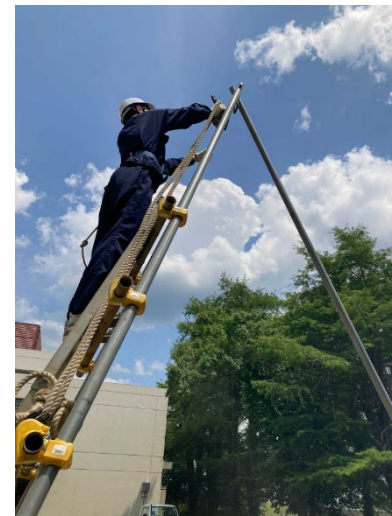
Boring survey at site ボーリング調査中の写真
