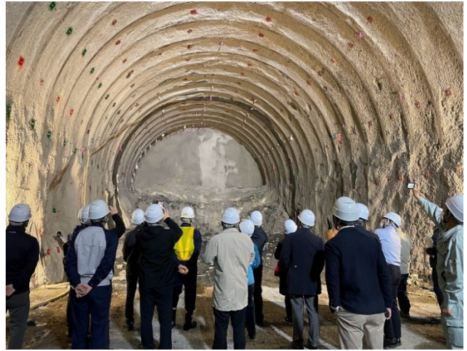
Site visit of the tunnel excavation トンネル掘削工事の現場見学
